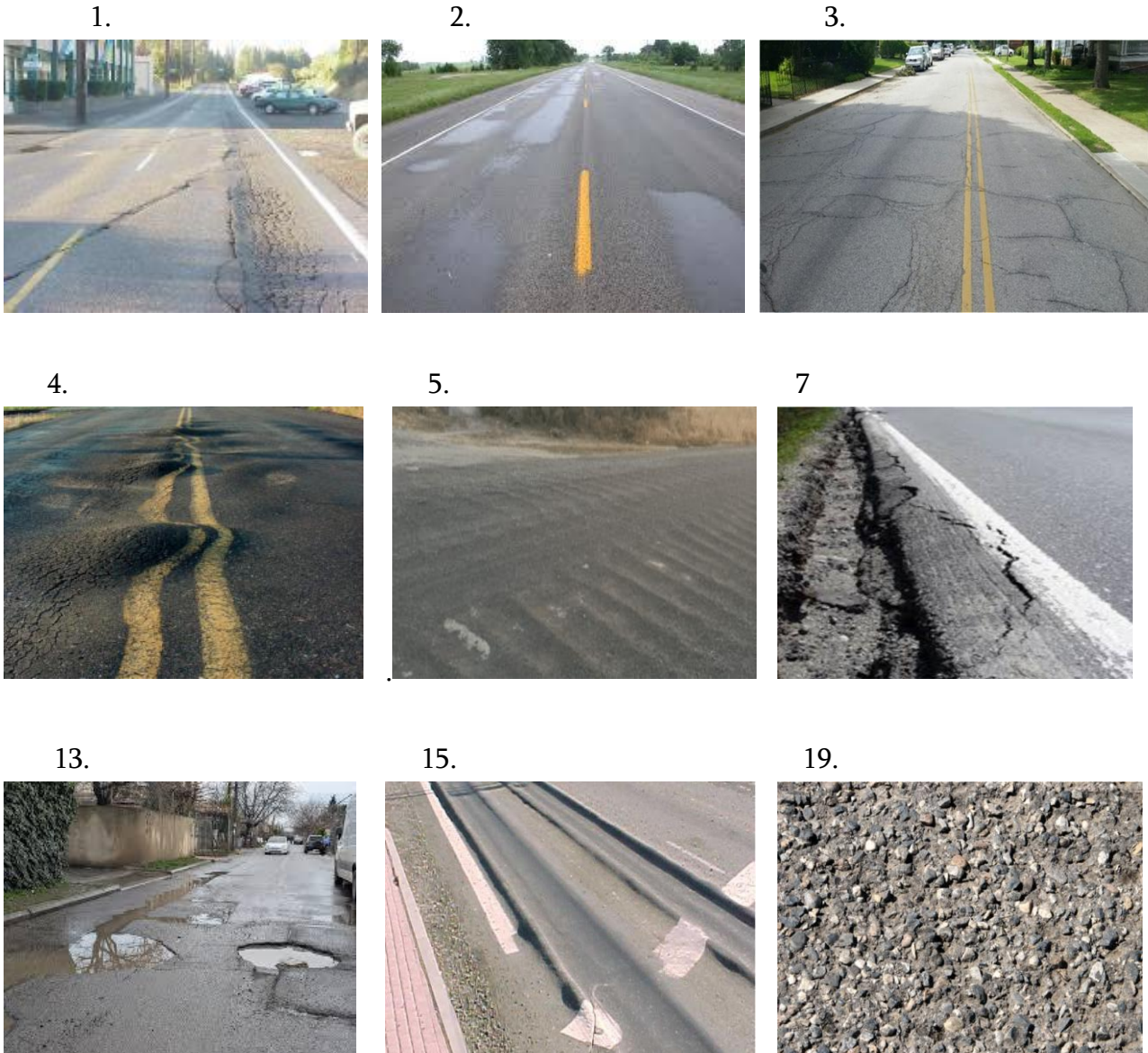
ნახ. 1. ასფალტბეტონის საფარის ძირითადი დაზიანებები
