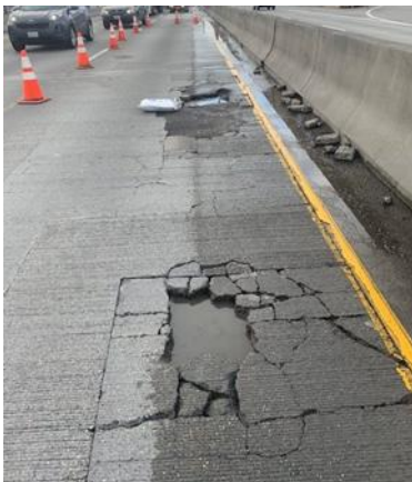
ნახ. 2. ორმოები და დაზიანებული გაფართოების ნაკერები ხიდზე:
