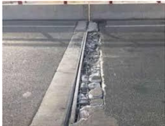
ნახ. 2. ორმოები და დაზიანებული გაფართოების ნაკერები ხიდზე:
