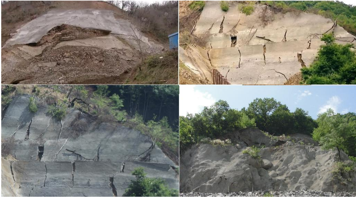
სურათი.1. მშენებლობისას გამაგრების შემდეგ ჩამოშლილი ფერდობები
